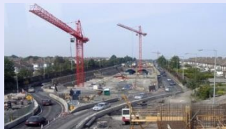
Travaux entrée de Casablanca
