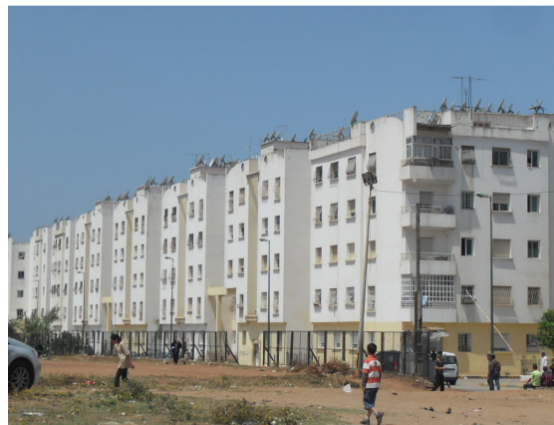
Logement social Quartier Tabriquet à Salé
